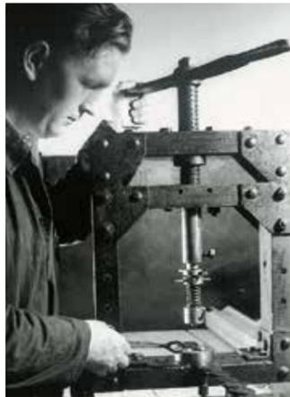
Herstellung der ersten Dichtungen auf einer Spindelpresse, 1929
