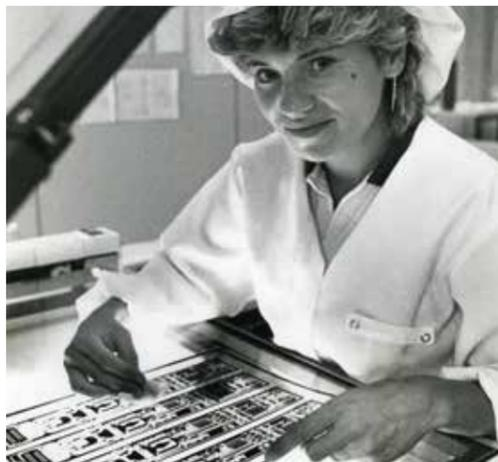
Herstellung von flexiblen Leiterplatten der Marke Simflex, 1984
