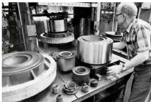
Fertigung von schwingungstechnischen Ultrabuchsen, 1957
