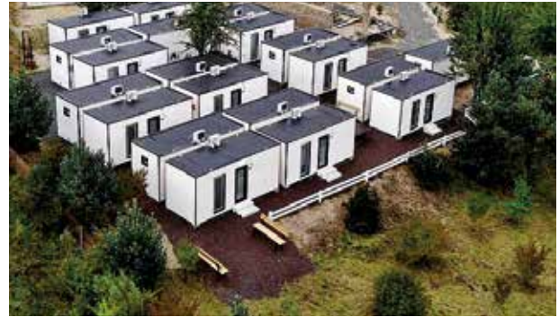
Freudenberg unterstützt die Ukrainian Friends Foundation, die an sicheren Orten in der Ukraine Containerdörfer errichtet.
