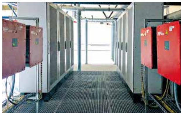
Das Energiespeichersystem besteht aus Schaltschranken, Batteriemodulen, Wechselrichtern und vielen Metern Kabel.
