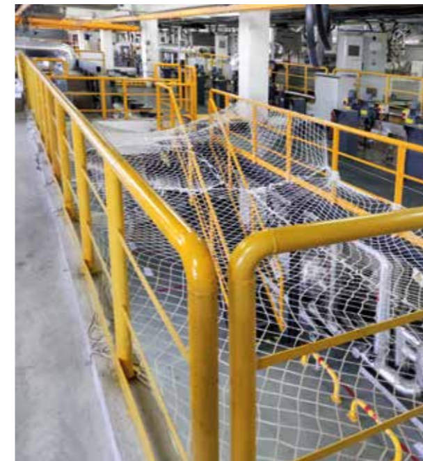
Installation einer „Zwischendecke“ zwischen dem 2. und 3. Stock. So kann die Temperatur im 2. Stock getrennt vom 3. Stock reguliert werden.
